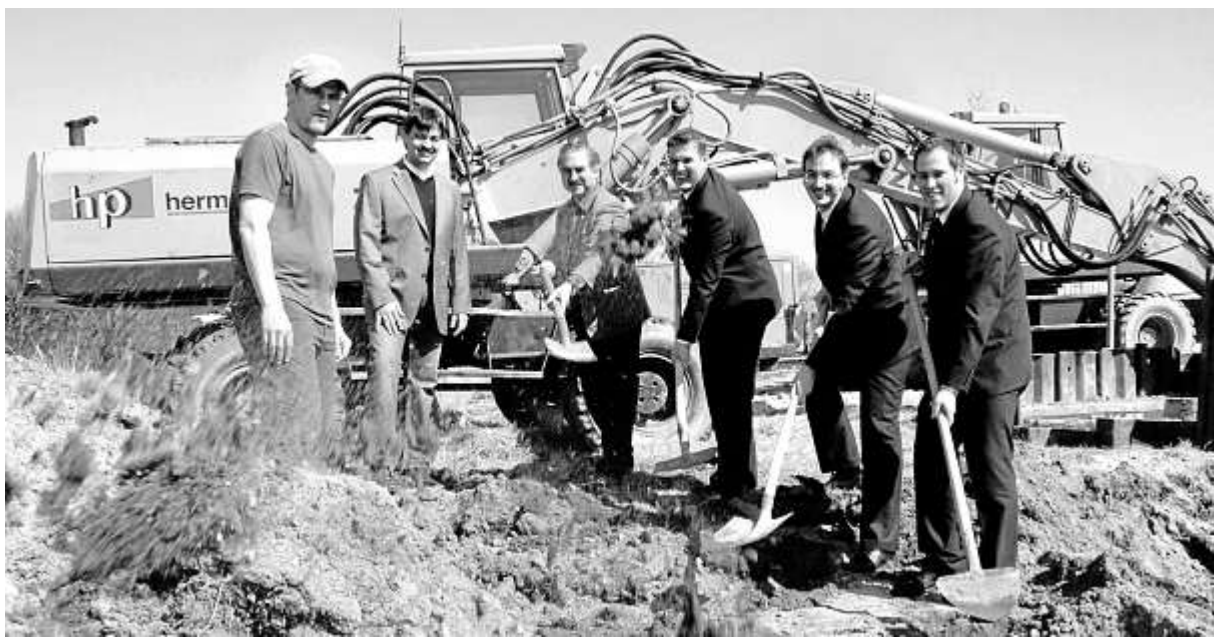
Bürgermeister Dr. Karl-Heinz Preißer, Architekt Roland Pflaum, Firmeninhaber und Geschäftsführer Bastian Braun, Vertriebsleiter Marco Striegl und Technischer Direktor Thomas Schimana beim Spatenstich für das Bauprojekt.
